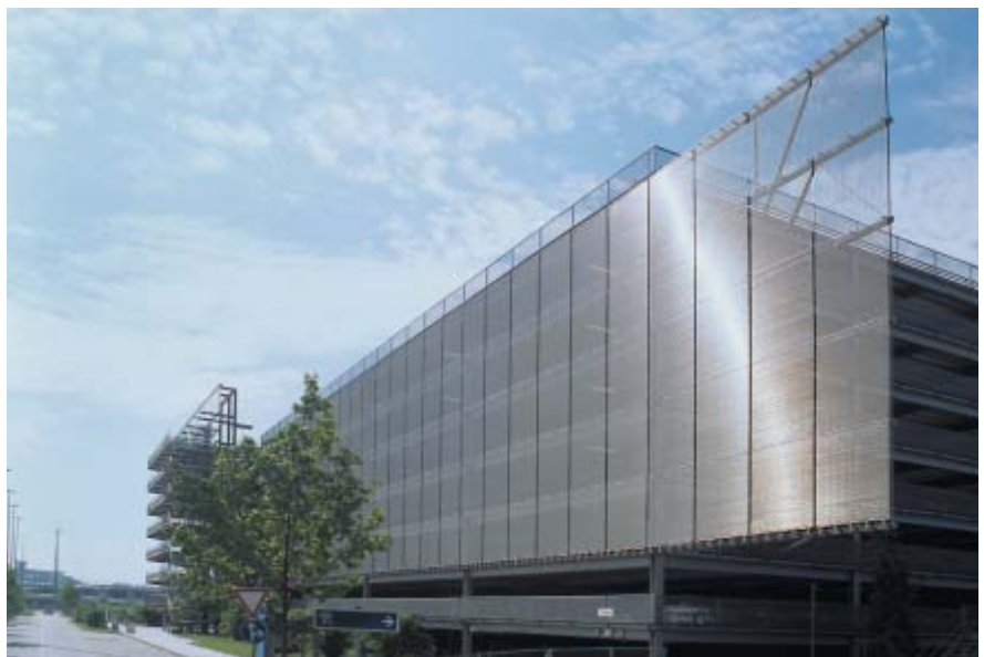
Revêtement de façade avec panneaux de toile métallique en acier inoxydable, Parking P3, aéroport Cologne/Bonn
